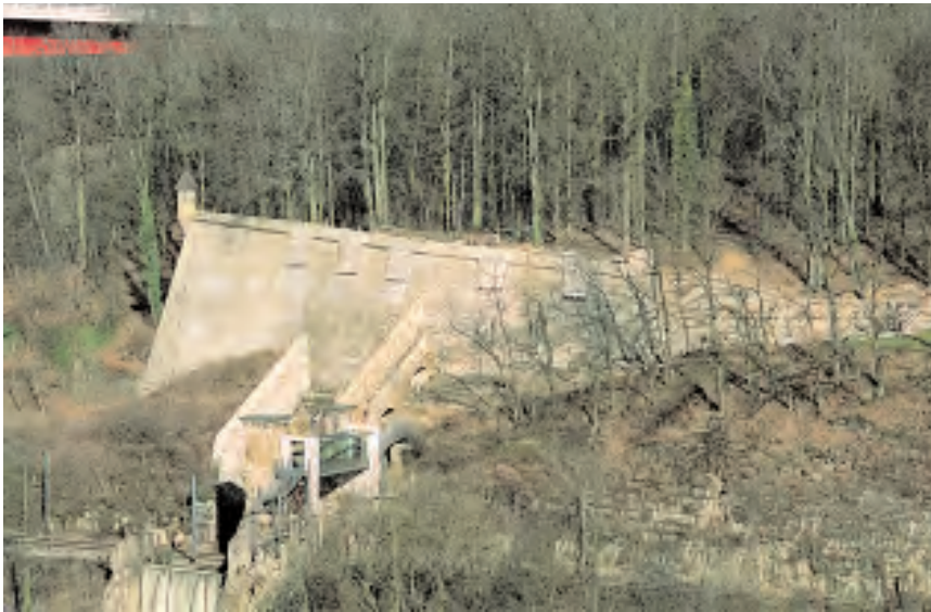
Die Flügelmauer der linken Halbbastion des Kronwerks Niedergrünwald mit dem Postenerker Nr. 1. Davor das Eisenbahntor mit der neuen Fußgängerbrücke.
