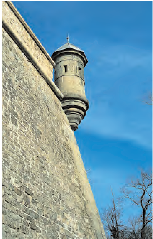
Blick vom Fuß der Flügelmauer der rechten Halbbastion des Hornwerks Obergrünwald auf den Postenerker Nr. 2
