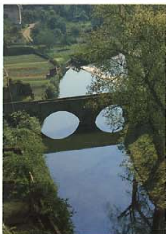
Mur et pont de Wenceslas (fin du XIVe siècle) intégrant la basse ville du Gronn dans le périmètre fortifié.
