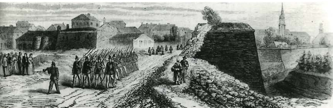
MANTELEMENT DES FORTIFICATIONS. — Brèche donnant passage à la rue Marie-Thérèse. — Croquis d'après nature par M. Gallérou.
